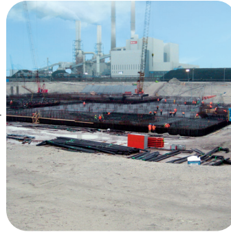
Bewehrungsarbeiten für Bodenplatte Power Island
