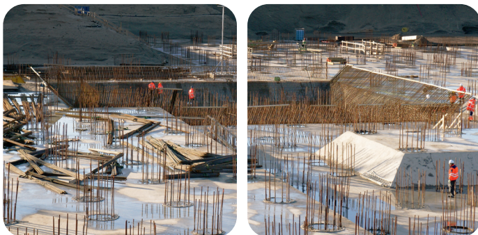
Fundamentversprung unter den Kesselhausstützen
